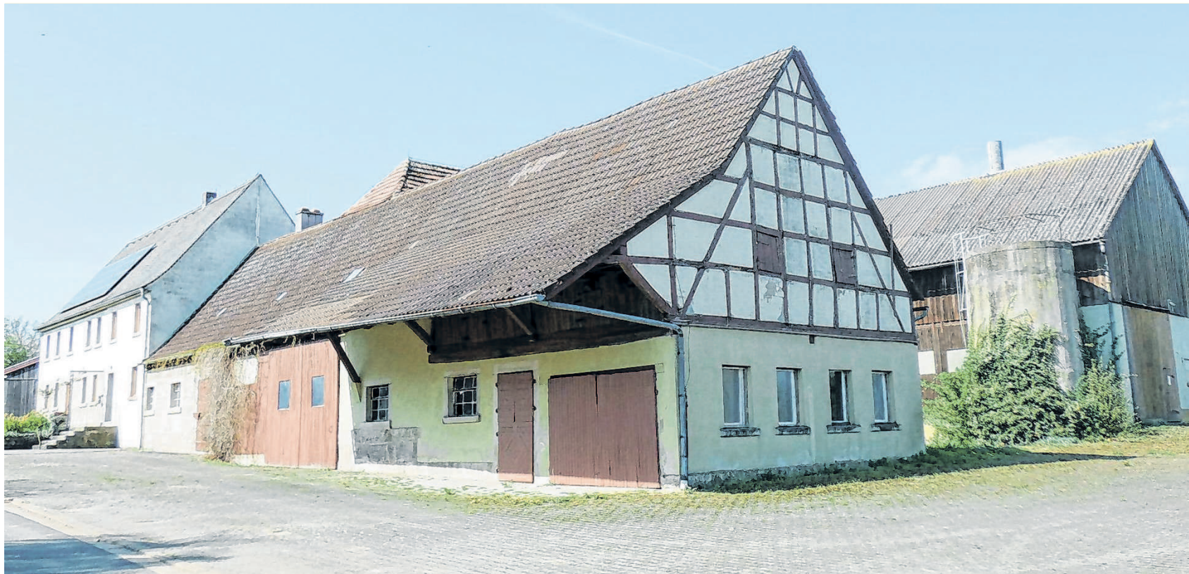
Eine Genossenschaft interessiert sich für eine ehemalige Hofstelle samt Grundstück in Gailshofen (Foto). Im Raum steht die Realisierung von Wohnraum für Menschen mit gesundheitlichen Einschränkungen. Im Gemeinderat wurde darüber informiert. Foto: Karl-Heinz Gisbertz
